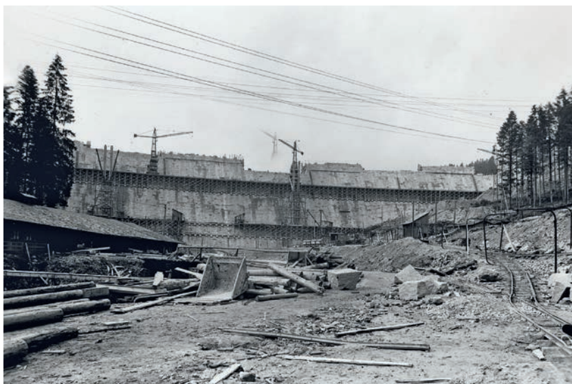
8 Staumauer der Schwarzenbachtalsperre.
