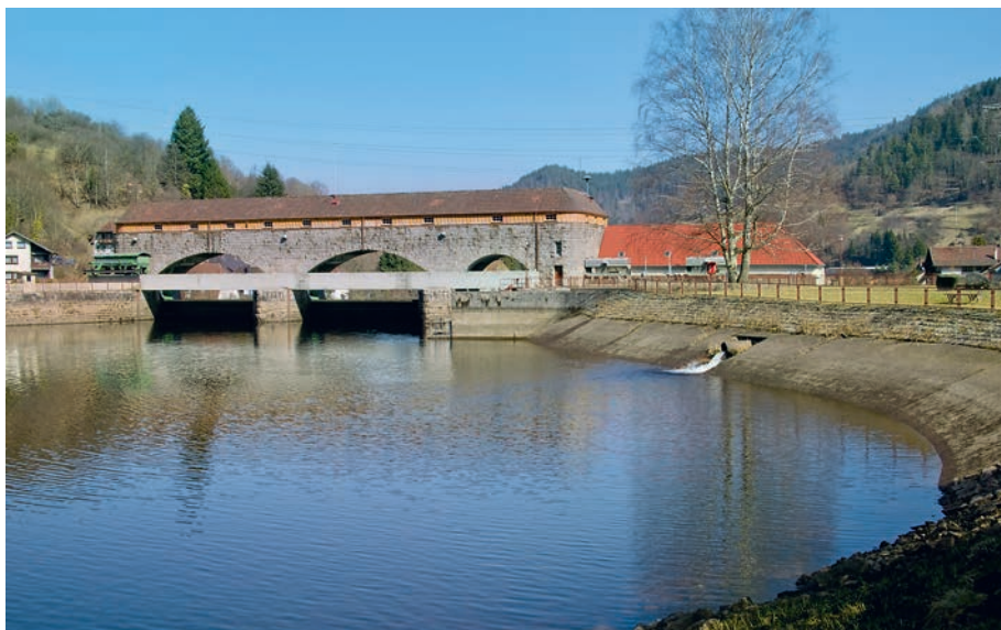
6 Niederdruckwerk mit Ausgleichsbecken.
